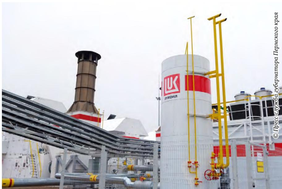
В Соликамском районе 19 августа запущена газотурбинная электростанция «Чашкино» в составе четырёх ГТЭС «Урал-4000», собранных «Протон-ПМ» по заказу «ОДК-Авиадвигатель»
